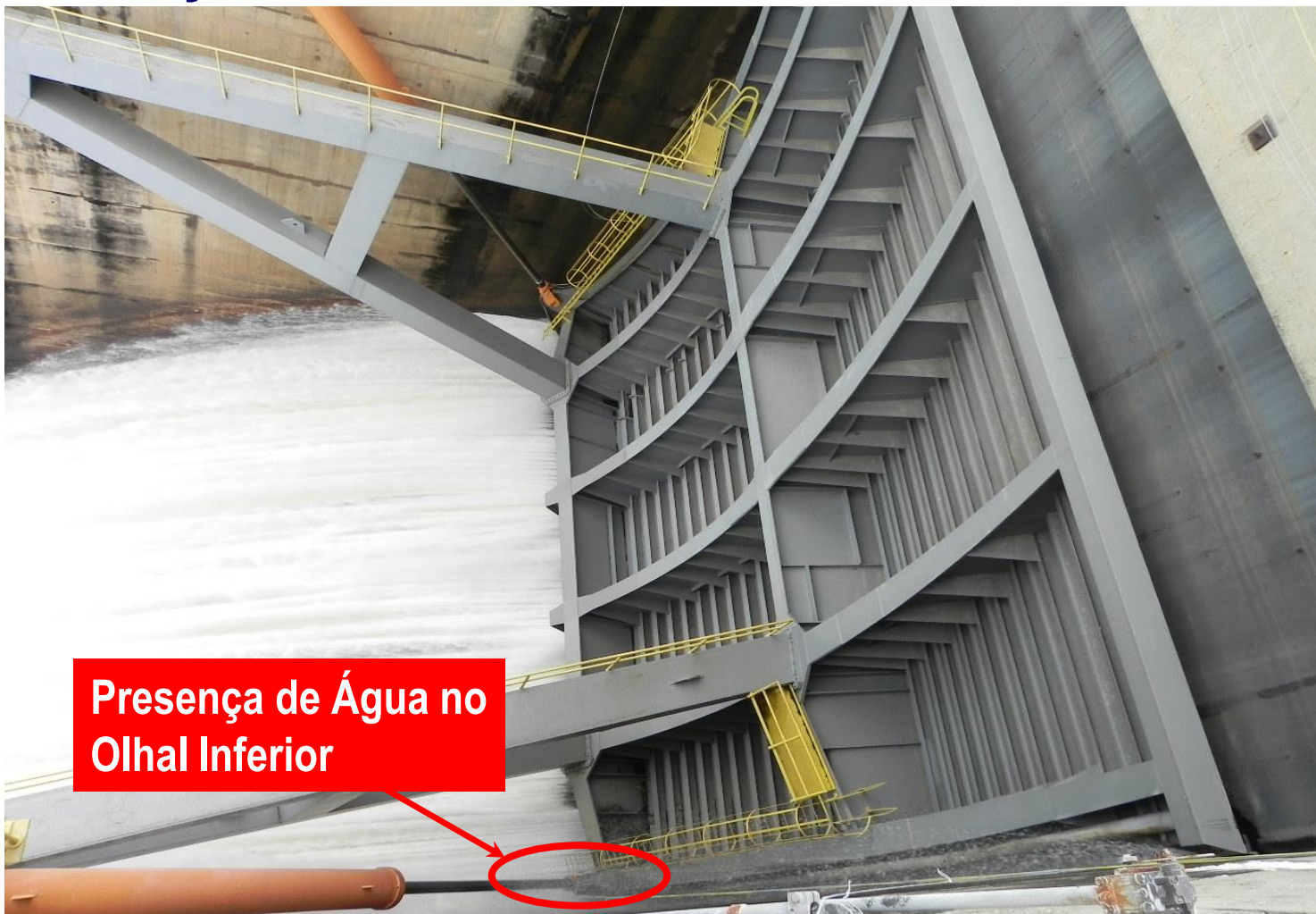
Foto 9 – Abertura da Comporta sem Stop Log
