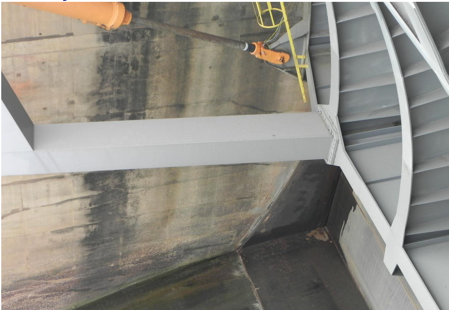
Foto 8 – Abertura da Comporta com Stop Log
