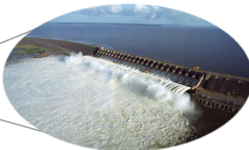
Foto 1 – Usina Hidrelétrica de Tucuruí Fonte: Próprio Autor
